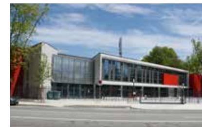
Salle Chatenoud - Annecy - C. Boidevaix, architecte
